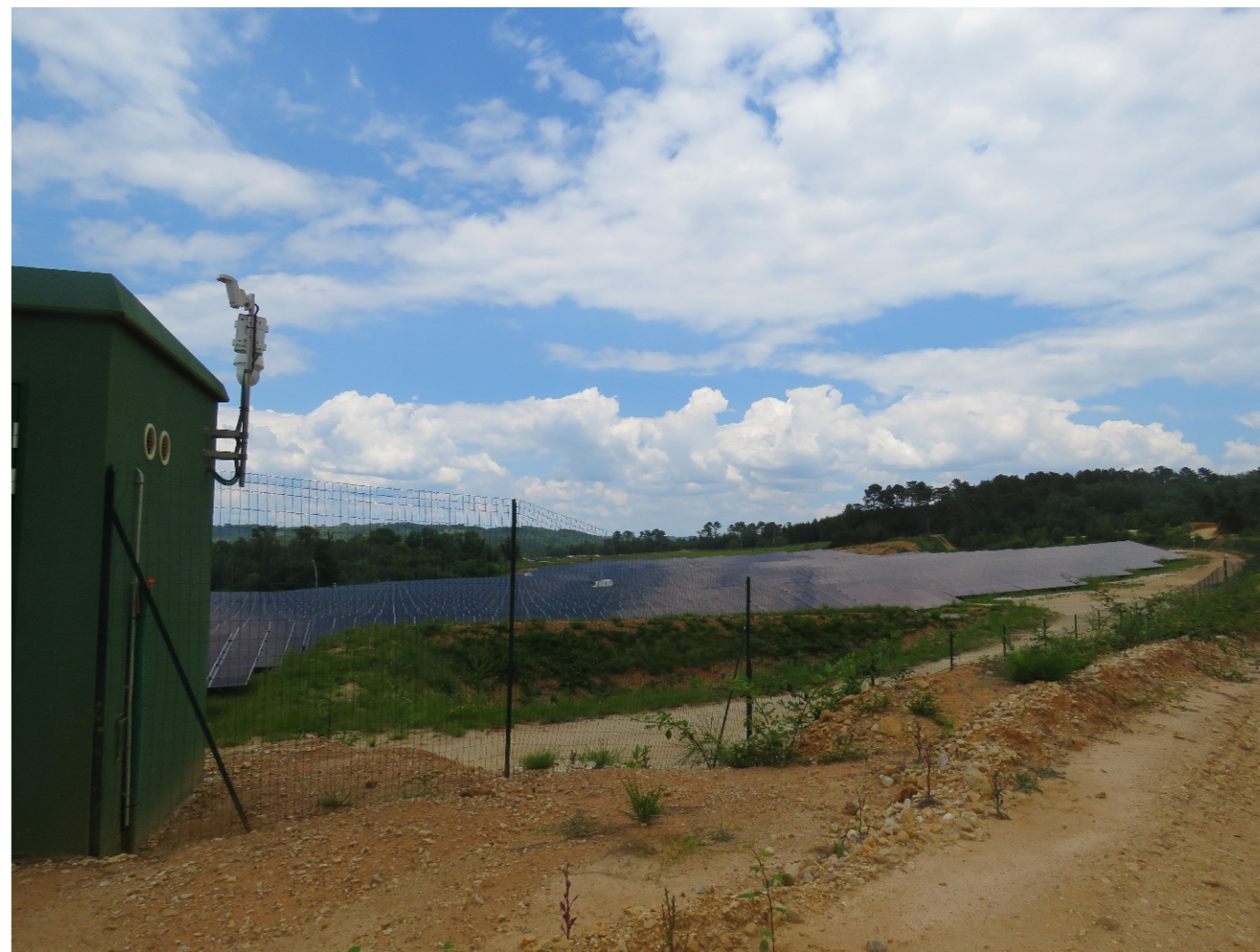
Etat final du site
