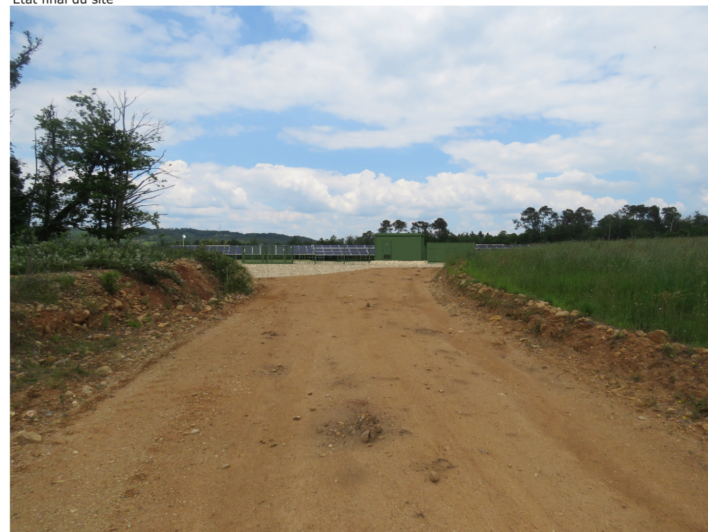
Etat final du site
